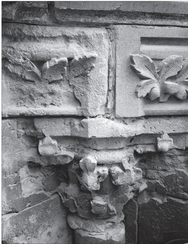
Peterskirche Leipzig: Am Peterskirchturm zu Leipzig hatte der Zahn der Zeit schon einen weitgehenden Formverlust der bildplastischen Elemente aus Sandstein bewirkt / Bild: Bennert Monumedia
