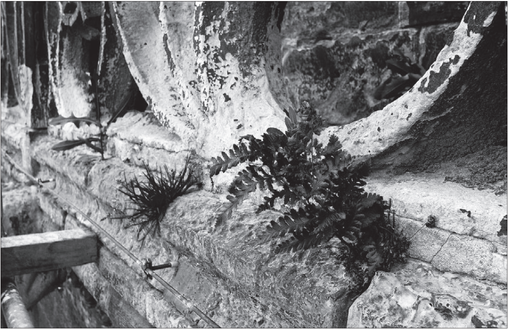
Dom Magdeburg: Pflanzen erobern die Fugen am Sandsteingesims des Magdeburger Domes / Bild: Bennert Monumedia
