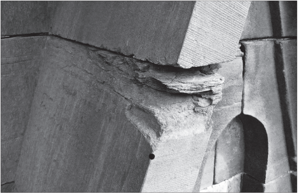
Lutherkirche Rudolstadt: Sandsteinzerstörung durch schalige Abwitterung an der Lutherkirche zu Rudolstadt / Bild: Bennert Monumedia
