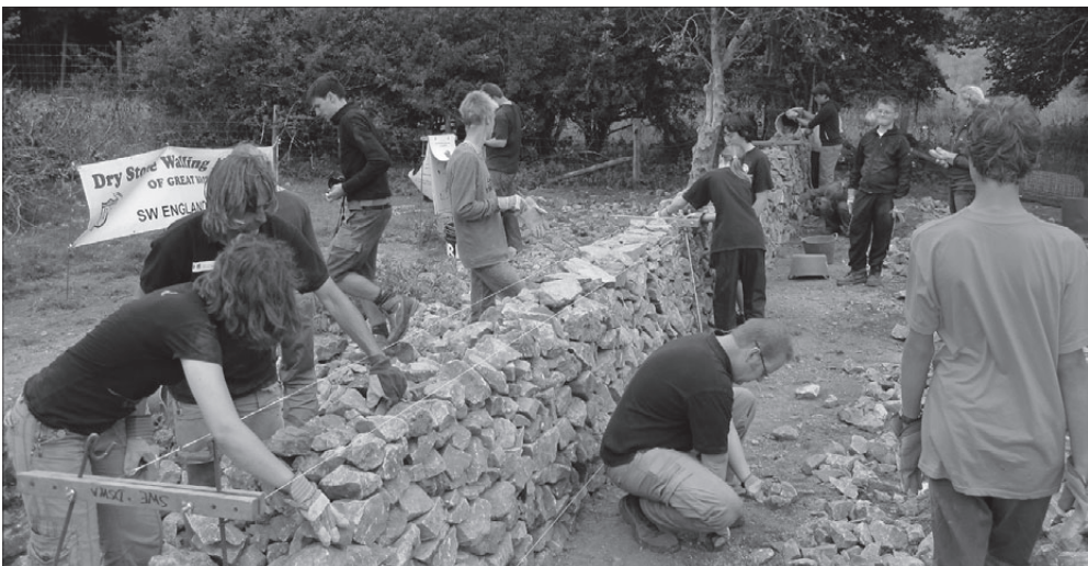
Junior Ranger beim Errichten einer Trockenmauer Foto: Peter Eichelkraut
