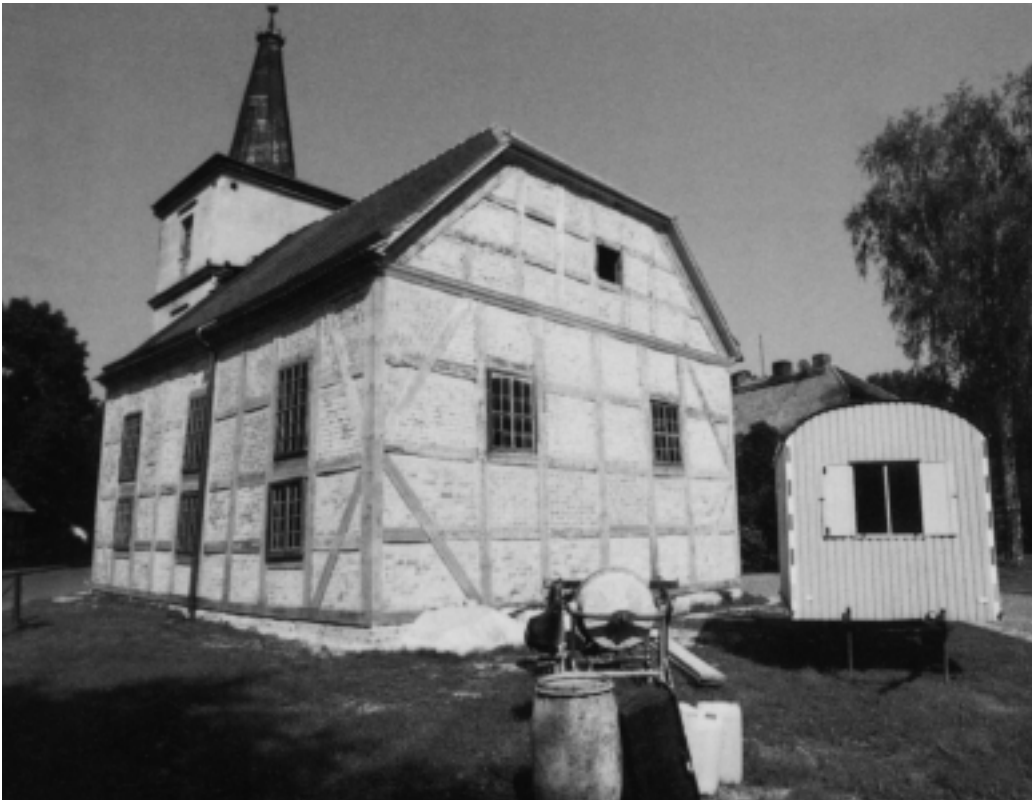
Bauarbeiten in Altwustrow
