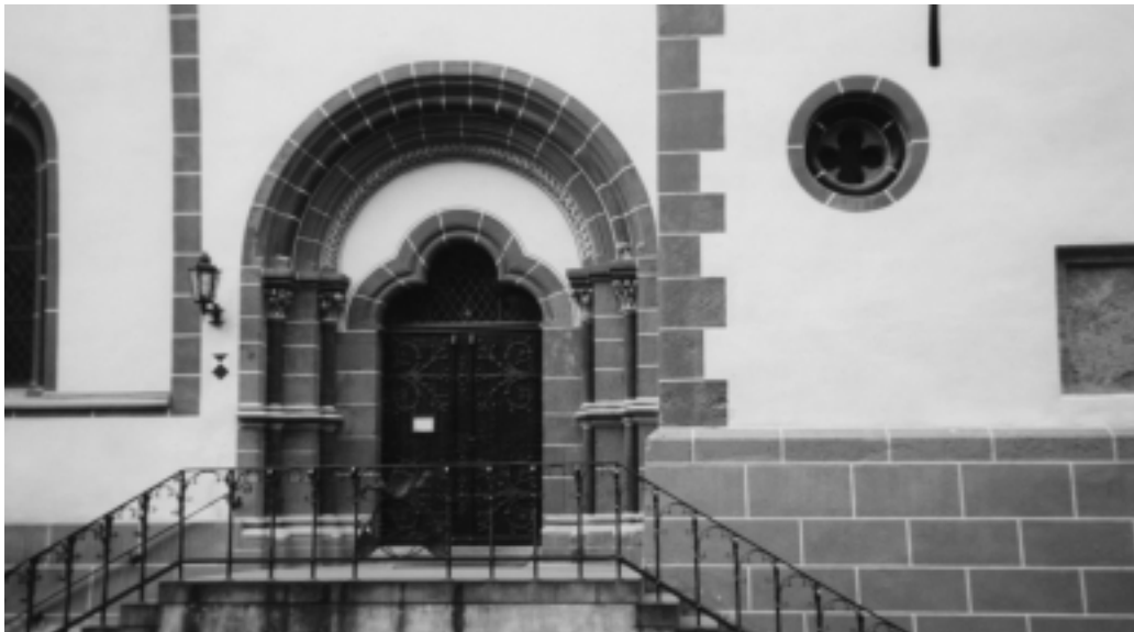
Peterskirche in Bacharach (Nordeingang)
